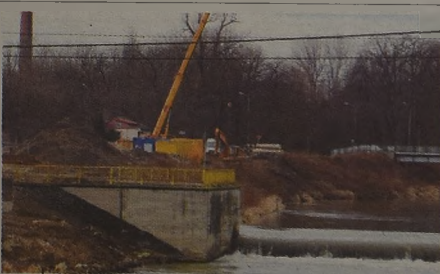
Remont koryta rzeki i samego zbiornika ma zagwarantować, że nie powtórzy się sytuacja z 1997 roku, kiedy zbyt mała przepustowość spowodowała spiętrzenie wody i doszło do zalania miasta.
