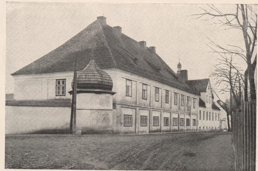
BASTIONSTÜRMCHEN UND WIRTSCHAFTSHAUS, BEIDE 1929 ABGEBROCHEN, AN DER EHEM. KLOSTERMAUER
