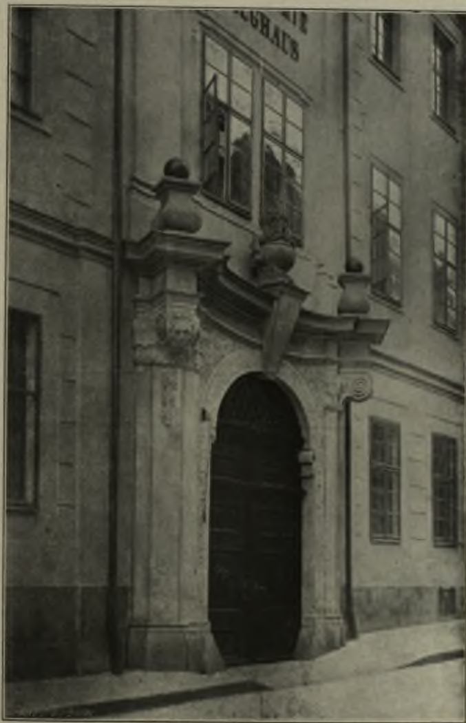
Portal des Artillerie-Zeughauses.
