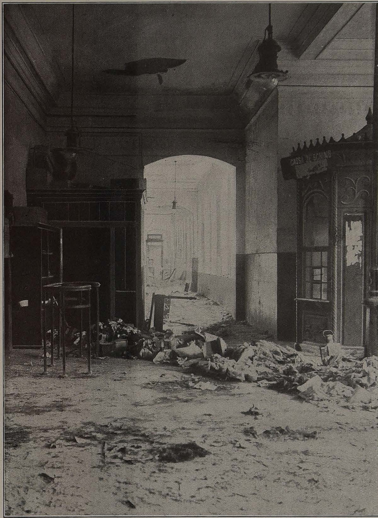
Im der Schalterhalle des Bahnhofs in Predeal.
