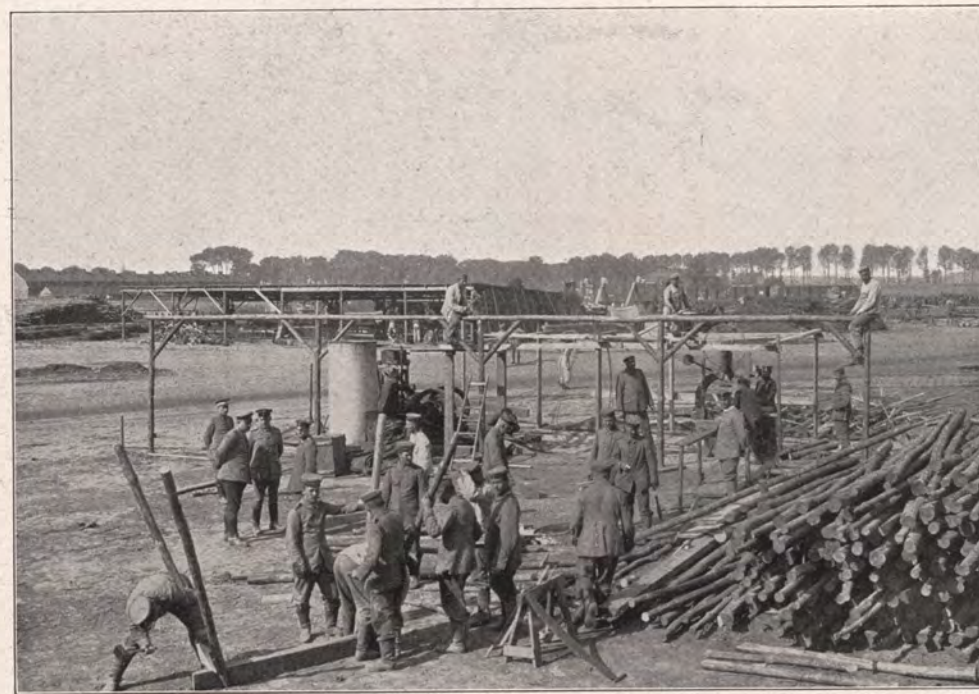
Kreislage in Betrieb; Anfertigen von Minierrahmen und Unterstandsbalken.
