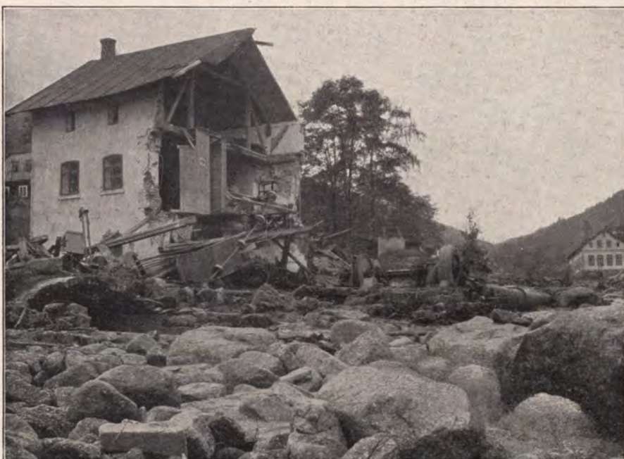
Zerstörte Glaschlenerei mit der freigelegten Turbine.
