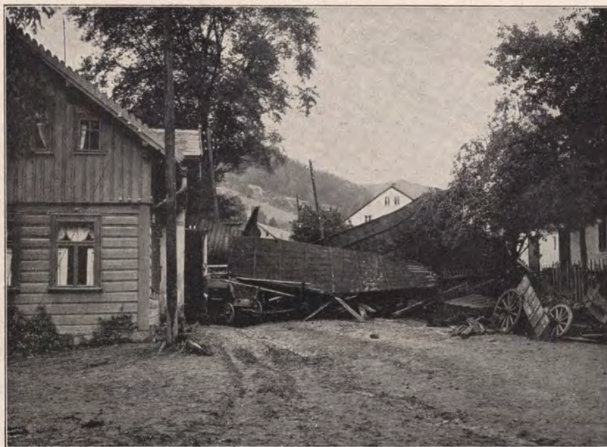
Durch angeschwemmte Dächer der zahlreichen zerstörten Häuser gesperrte Straße in Dörfendorf.
