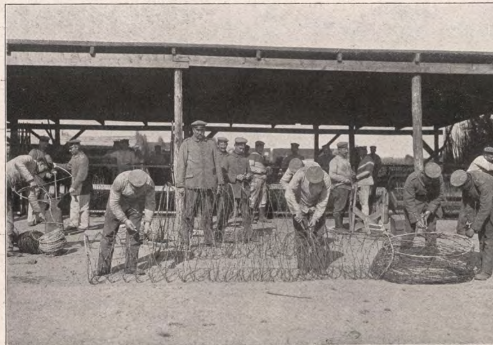
Bei der Herstellung von Drahtbindernissen. Aus einem Pionier-Hauptpark in Flandern.
