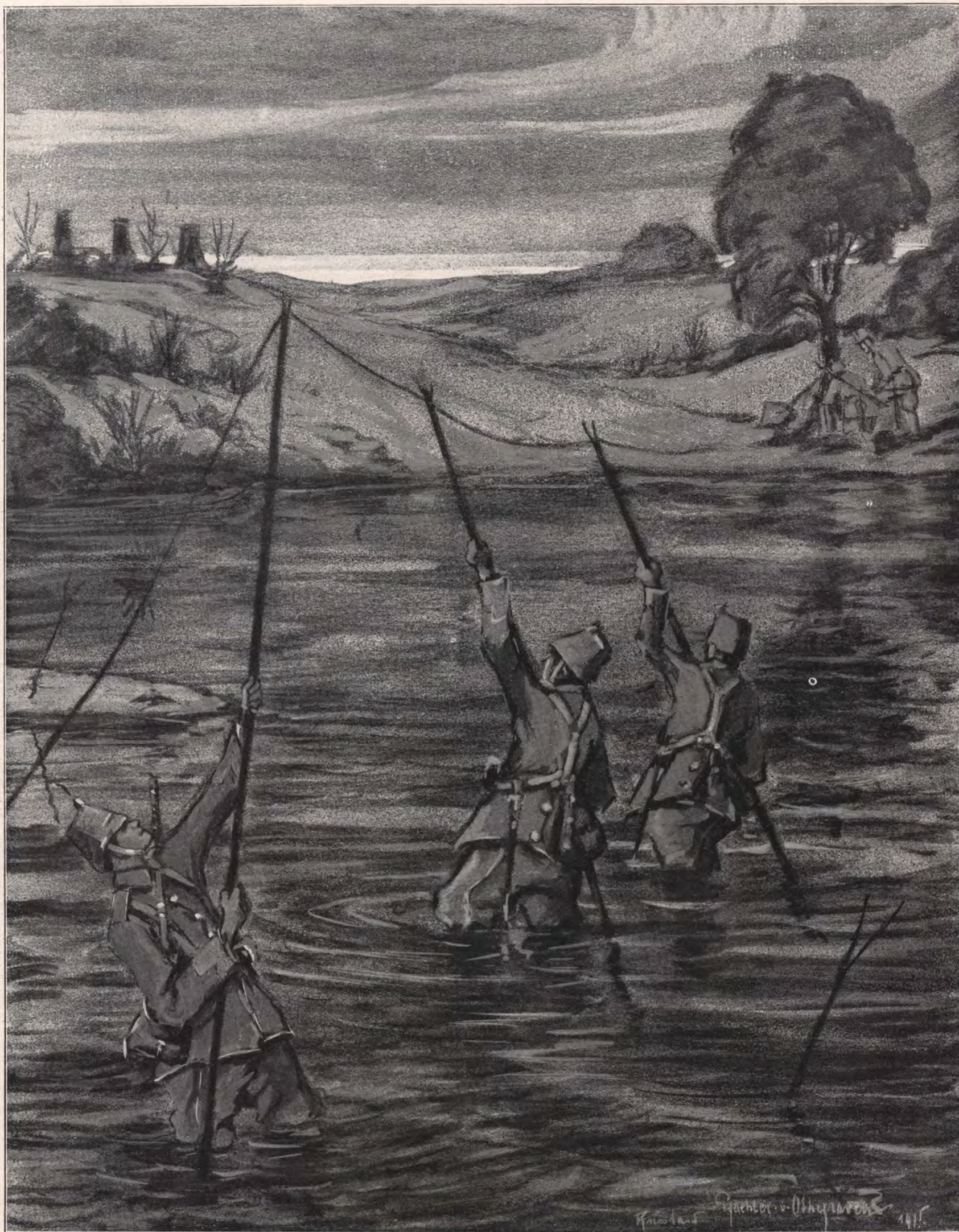
Vom östlichen Kriegsschauplatz: Ein Telephonkabel wird über einen Fluß gelegt.
