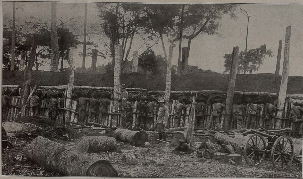
Bau einer Feldstellung bei Ummam. (phot. Hauptmann v. Hagen.)
