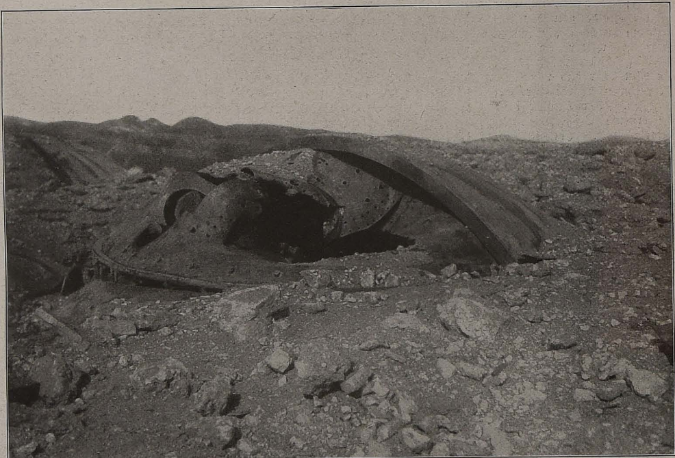
Eine gepanzerte Kuppel der italienischen Panzerfestung Monte Berona mit einem Wolltreffer. (Phot. H. G.)
