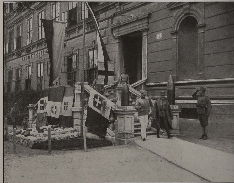
Armee-Kommandant Generaloberst v. Rohr beim Verlassen eines Kommandogebäudes an der österreichisch-ungarischen Südwestfront. Vor dem Gebäude sind erbeutete italienische Fahnen angebracht.
