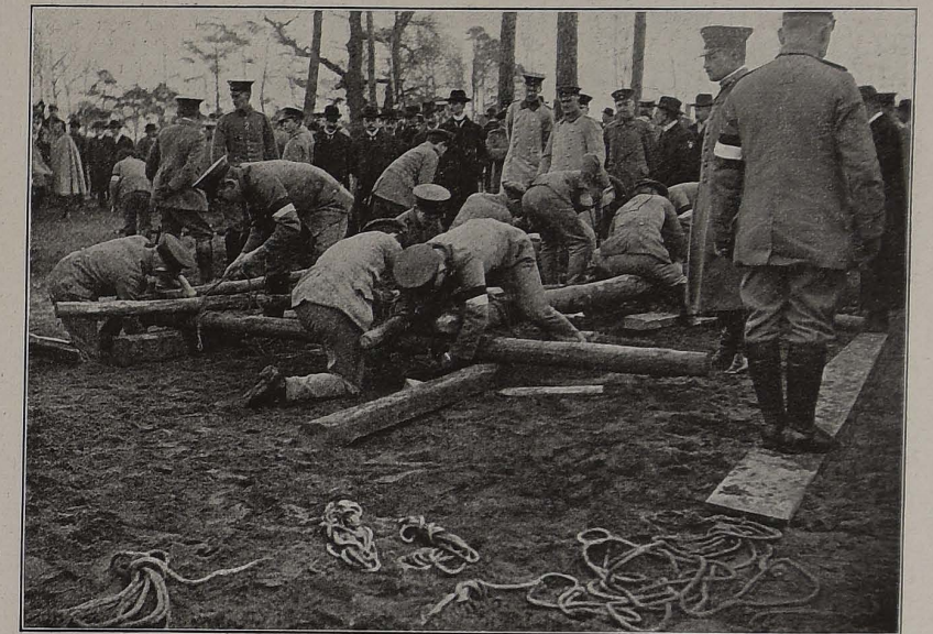
Das Zusammenlegen und Ausbauen einer improvisierten Brücke.
