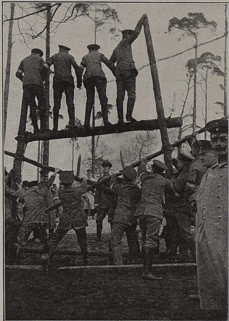
Belastungsprobe der fertigen Brückenbalken.
