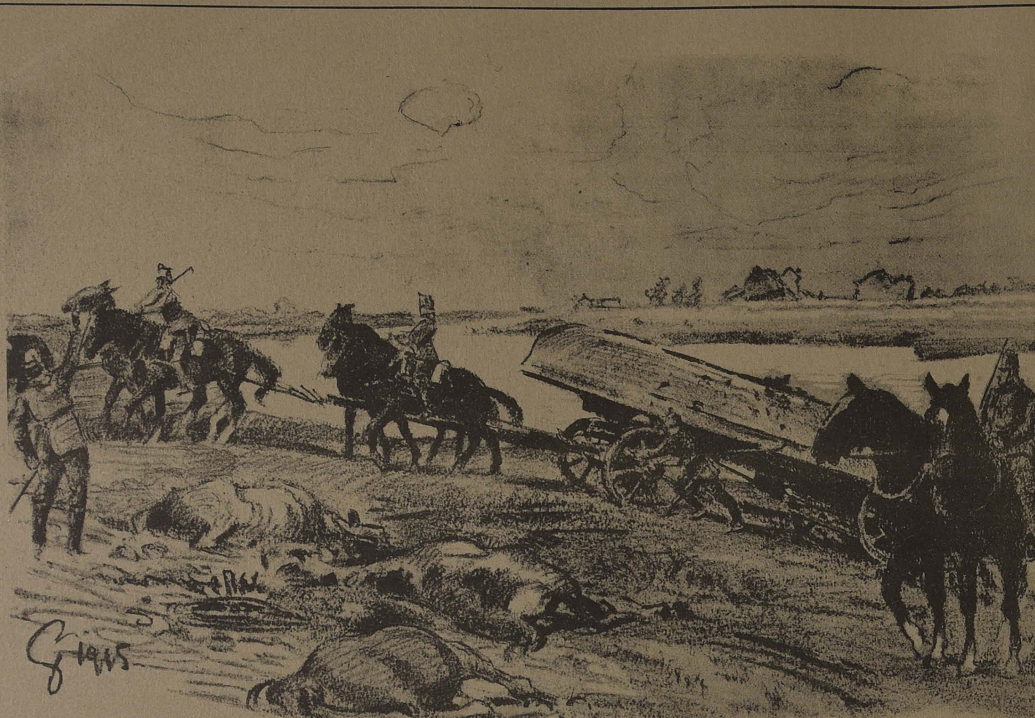
Einbringen zerstörter Pontons.
