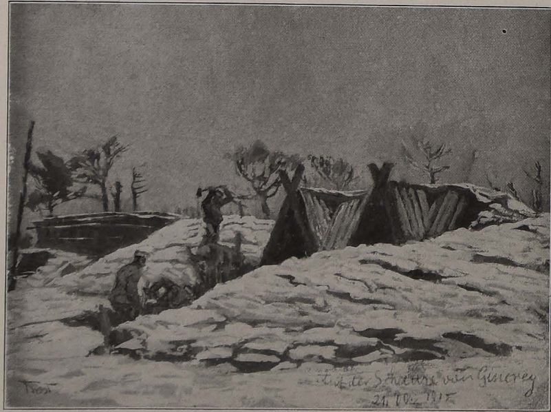
Beim Bau von Unterständen auf den Schanzen bei Gincrey.
