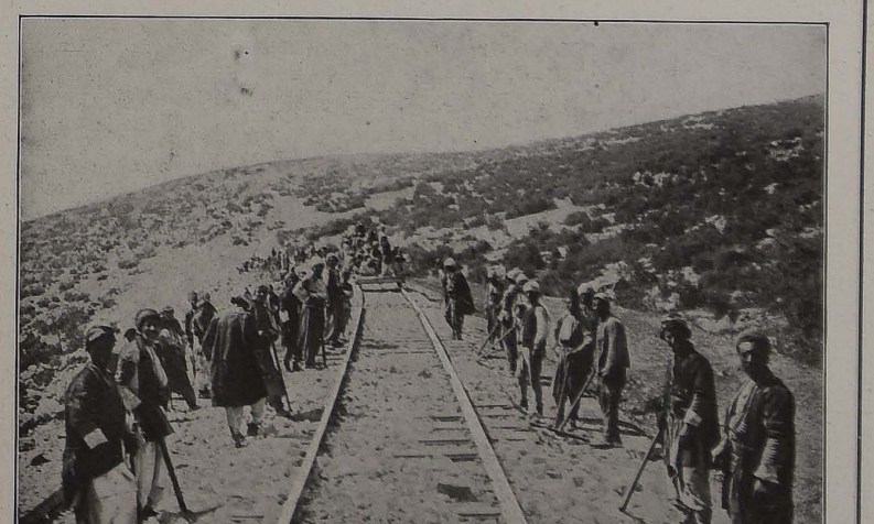
Kurdische Arbeiter an der Baustrecke der Bagdad-Bahn zwischen Adana und Aleppo.
