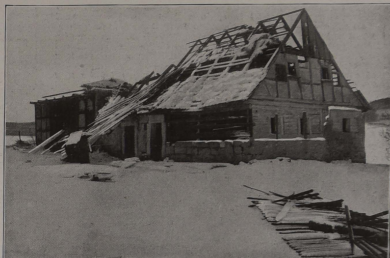
Zerstörtes Wohnhaus in Mengersdorf.
