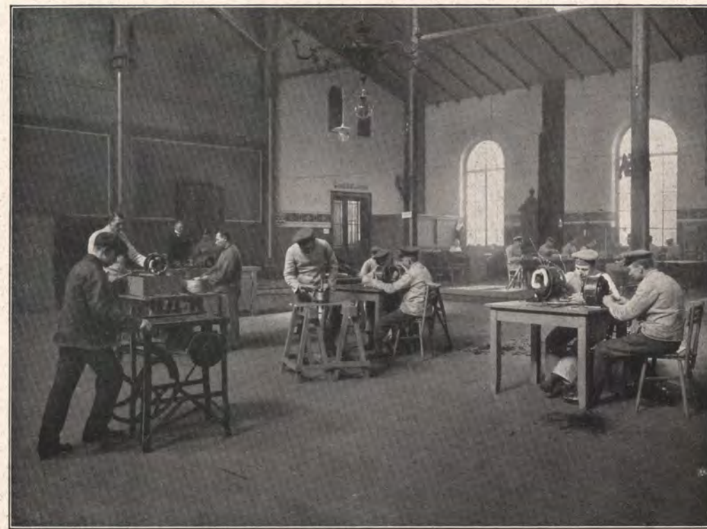
Werkstatt für Unterwider (Elektromotorenbau).
