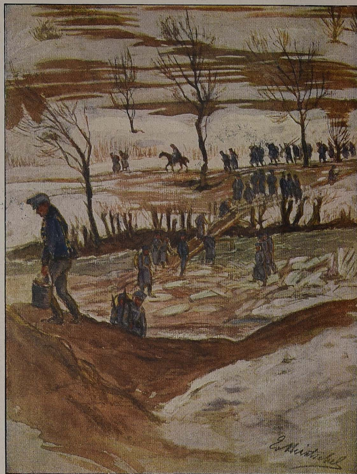
Bau einer Holzbrücke bei Wyrzky Górne.
