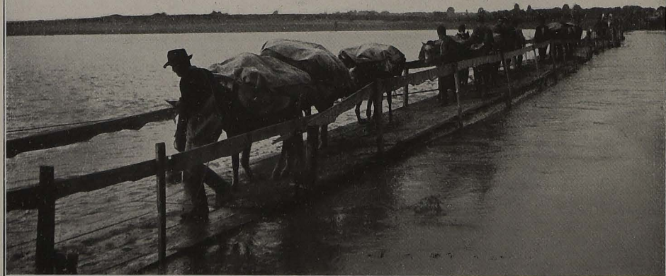
Eine Bagage- und Proviantkolonne beim Passieren der Donau auf einer Schwimmbrücke.
