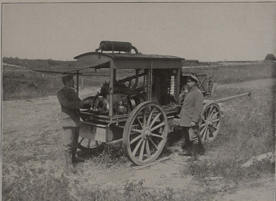
Der Wagen mit dem Motor und der Dynamomaschine für die Erzeugung des elektrischen Stromes.
