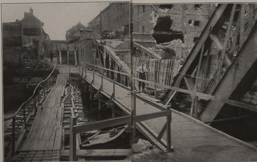
Befestigungsarbeiten an einer gesprengten Brücke.
