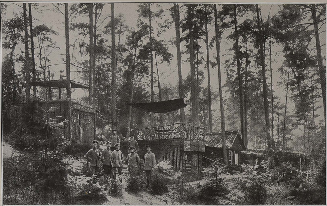
Südlich angelegte Blockhäuser.
