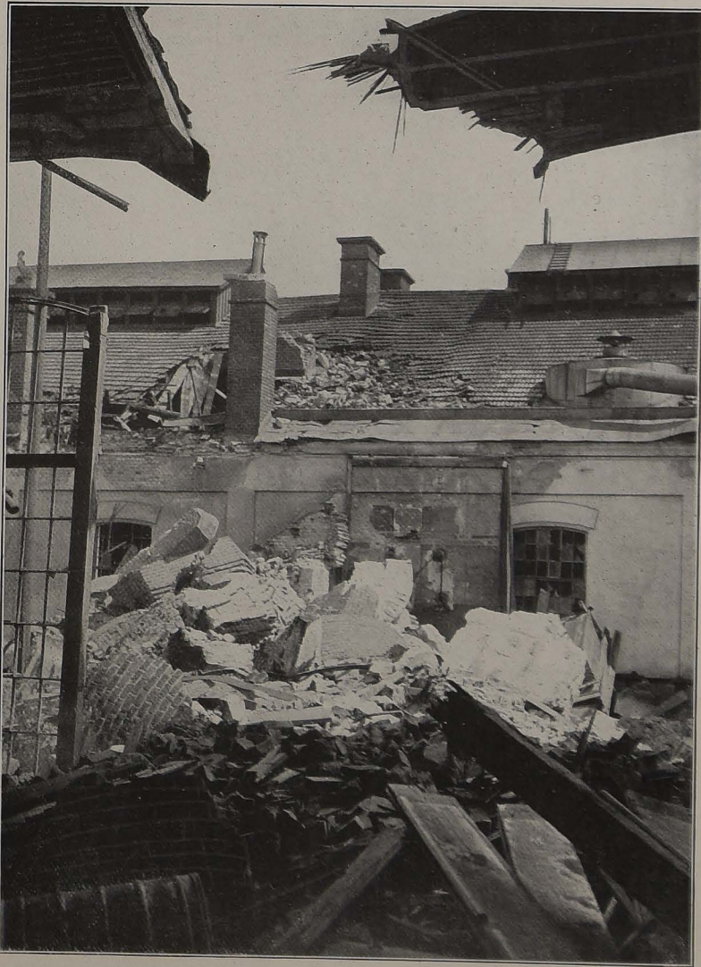
Wirkung eines 30,5-cm-Motor-Mörsergeschosses in einer Fabrikanlage bei Stuy. In dem niedergelegten Schornstein befand sich ein russischer Beobachtungsposten. (Phot. Gebr. Gaedel.)
