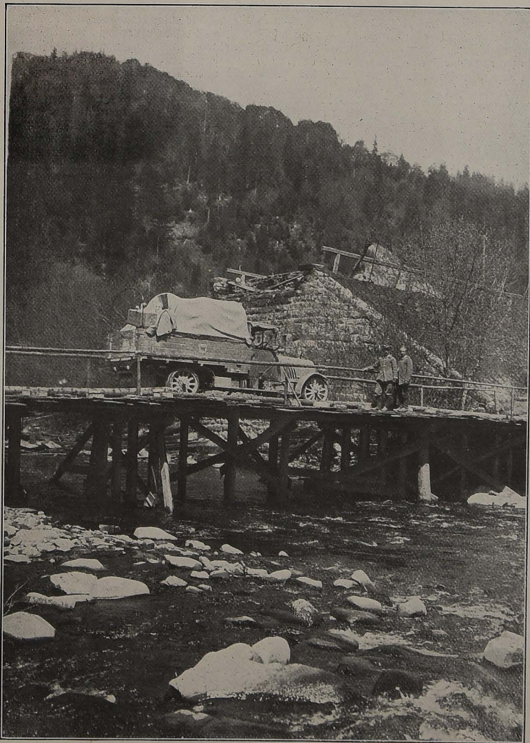
Ein deutsches Militärautomobil beim Passieren einer provisorischen Holzbrücke über einen Fluß in Galizien. (Phot. Gebr. Gaedel.)
