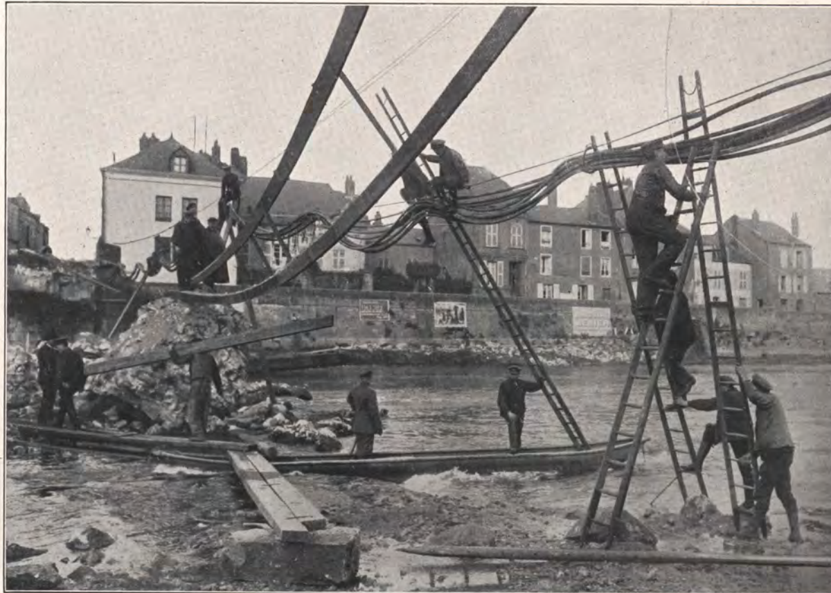
Unsere Eisenbahntruppen in Feindesland: Deutsche Telegraphenarbeiter beim Legen von Kabeln über eine von den Franzosen zerstörte Brücke.
