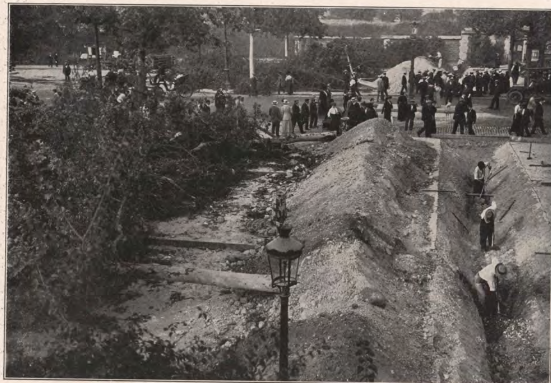
Paris wird in Verteidigungszustand gesetzt: Aufwerfen von Schanzgräben bei Porte Maillot. Vorsichtsmaßnahmen in Paris für den Fall der Belagerung. Nach photogr. Aufnahmen aus Paris.
