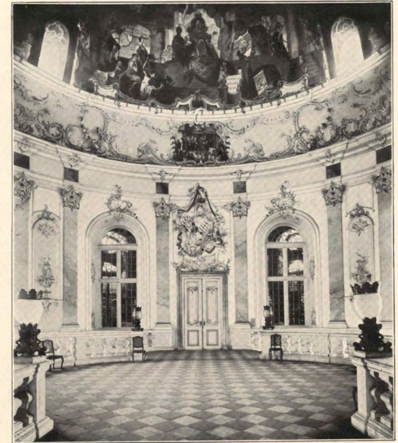
VOM SCHLOSS IN BRUCHSAL Der Treppensaal im Corps de Logis, von 1752. — Text S. 237 und 242
