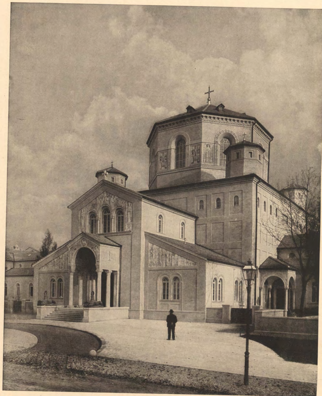
HANS GRÄSSEL Der neue nördliche Friedhof in München Ansicht des Mittelbaues gegen die Straße
