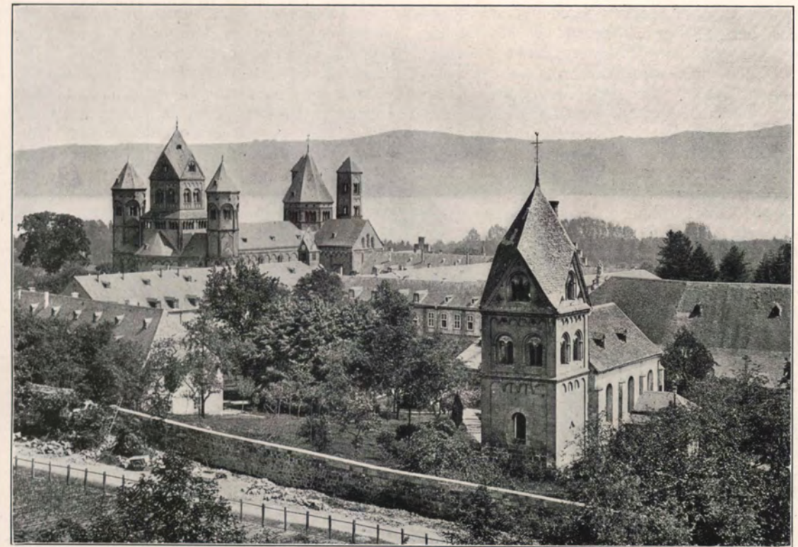
MARIA LAACH, SÜDWESTLICHE ANSICHT
