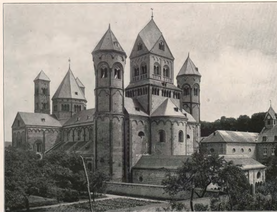
DIE ABTEIKIRCHE IN MARIA LAACH, NORDWESTLICHE ANSICHT
