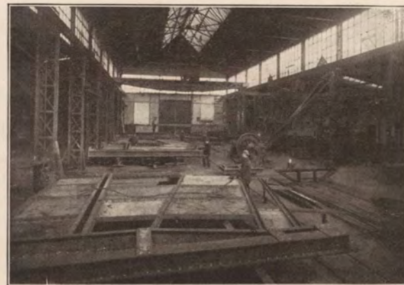
Teilansicht: Abt. Eisenkonstruktion
