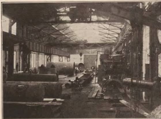
Teilansicht: Abt. Kesselschmiede
