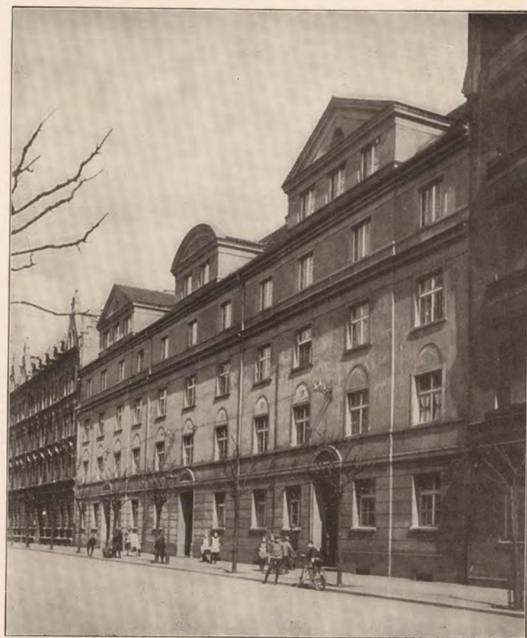
Abb. 15. Städtische Wohnhäuser an der Löschstraße
