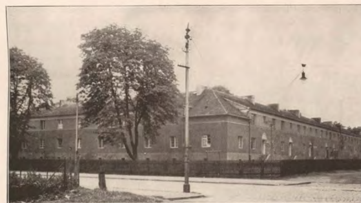
Abb. 17. Umbau der Ställe der alten Kaserne zu Flüchtlingswohnungen (Straßenansicht)
