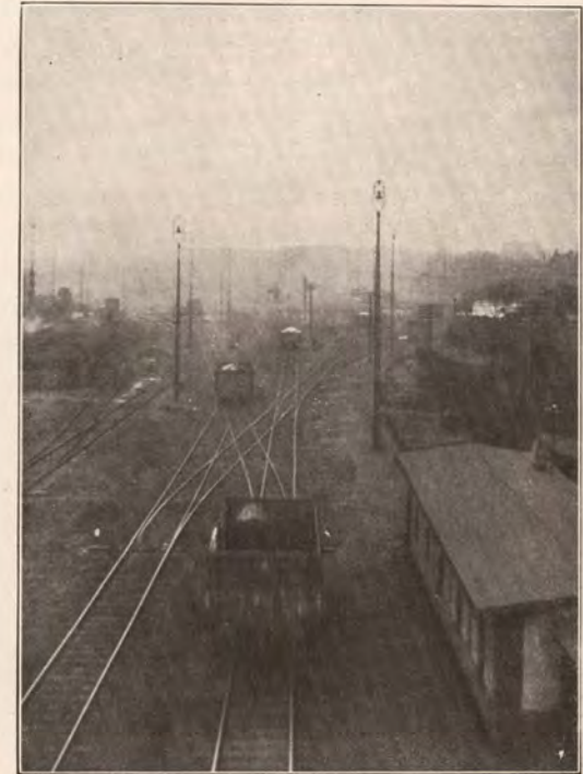
Abb. 3. Blick vom Stellwerk Die Wagen rollen vom Ablaufberg in die Richtungsgleise. (Die jenseitig erforderliche Umstellung der Weichen erfolgt durch kleine Motoren, die an der Weiche angebracht sind und vom Stellwerk aus durch Einschalten des Stromes bedient werden)
