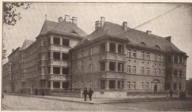
Abb. 12. Wohnhäuser der Gräfl. Ballesfremischen Verwaltung an der Ecke Moltke- und Bitterstraße
