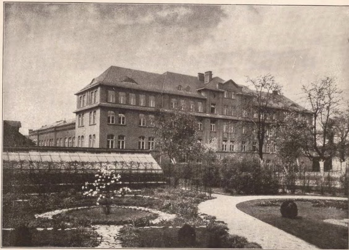
Das Hauptverwaltungsgebäude der Gesellschaft in Gleiwitz (Rückansicht)
