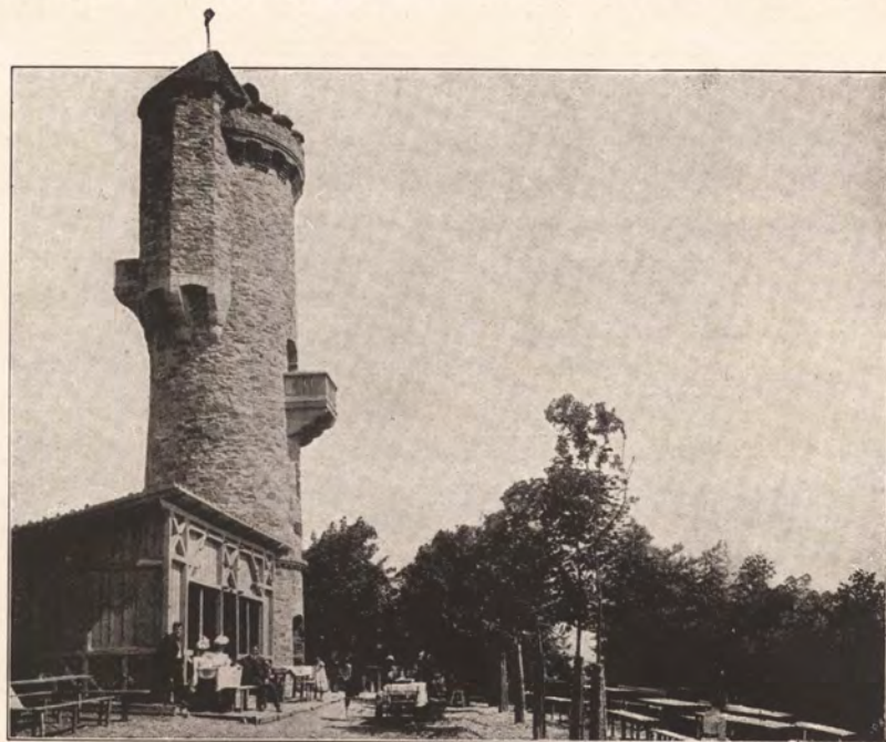
Aussichtsturm (Hohenzollernwarte) auf dem Holzberg
