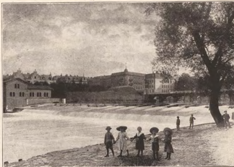
Spaziergang am Neissewehr vor dem Bau des neuen Wasserwerkes
