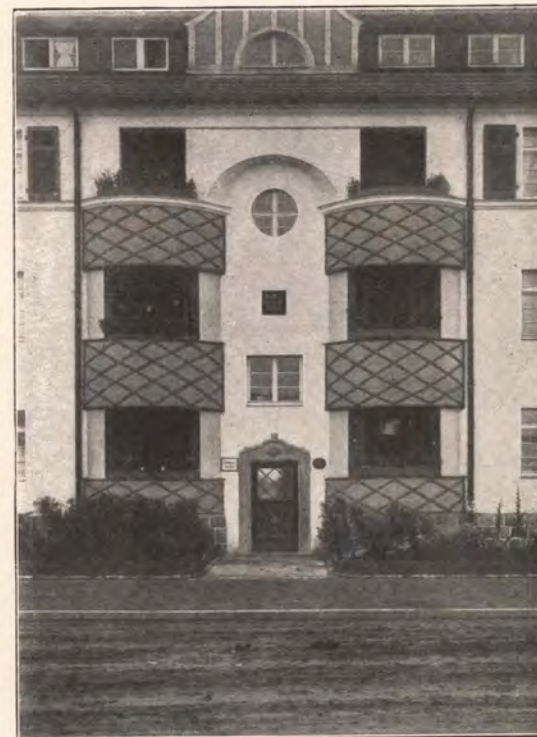
Block VIII: Fassadendetail Marienstrasse 35
