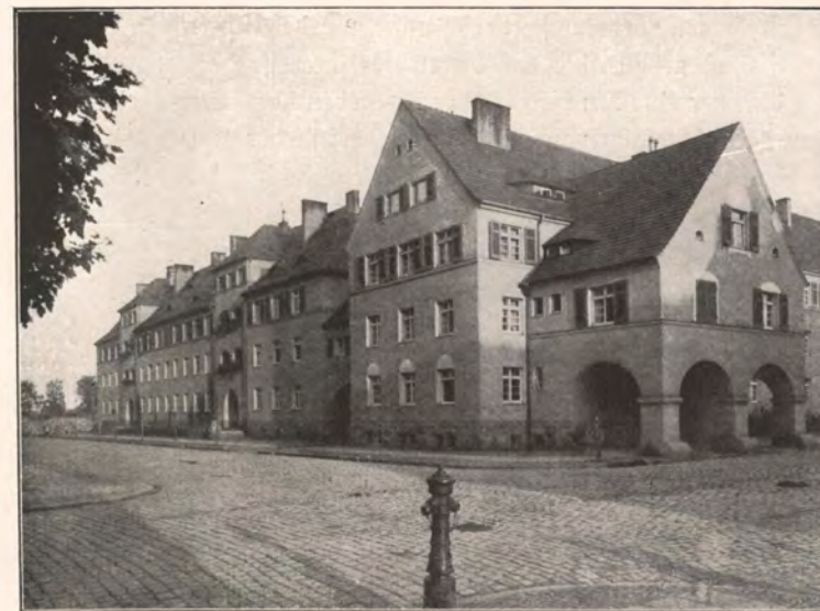
Block II und III: Marienstraße, Neubauten. (Erbaut 1920/21)
