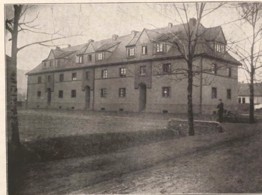
Siedlungshaus der Gemeinnützigen Baugesellschaft Ziegenhals
