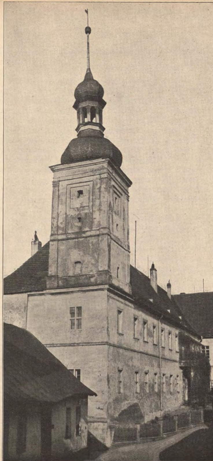
Das Schloß (ehemaliges Seminargebäude).
