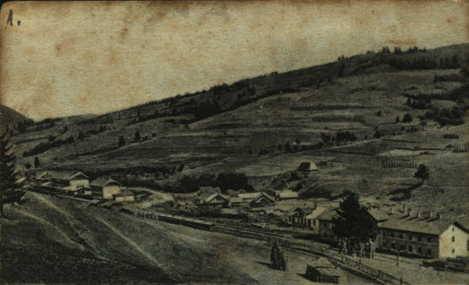
Totalansicht samt Bahnhof Stacya Kolejowa Ławoczne
