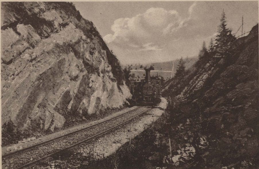
Pociąg przed tunelem na szlaku z Synowódzka do Skolego
