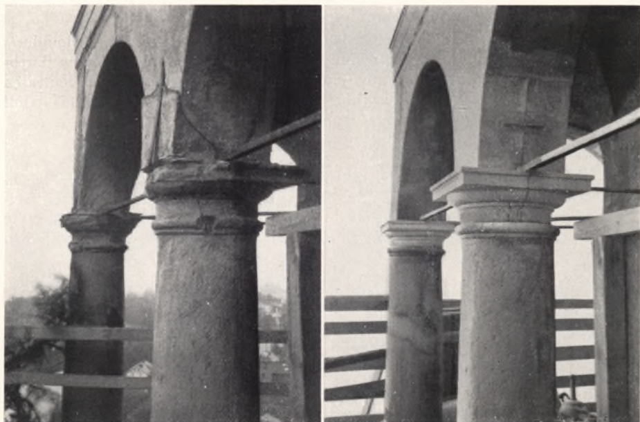
76 u. 77. Glatz. Rathausurm. Säulen am Oberbau vor und nach der Instandsetzung
