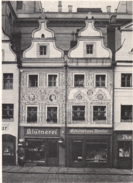
106. Liegnitz. Heringsbuden nach Freilegung und Ergän- zung des Sgraffitoputzes
