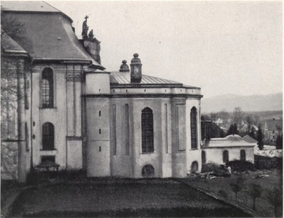
97. Grüssau. Fürstengruft nach der Umdeckung mit neuer Attika
