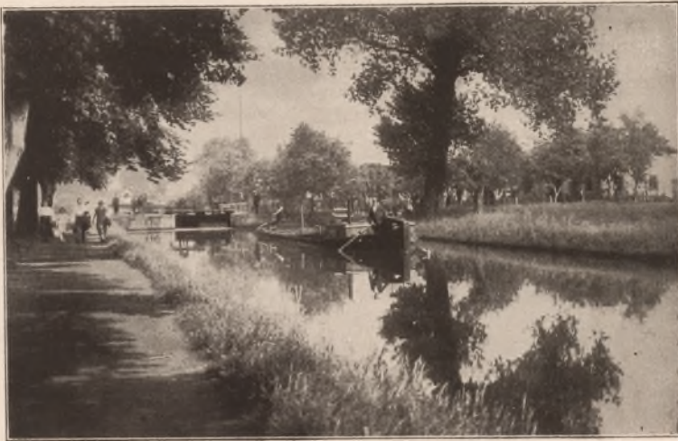
Der Klodnikkanal (Blickrichtung auf Schleuse 17, Petersdorf)
