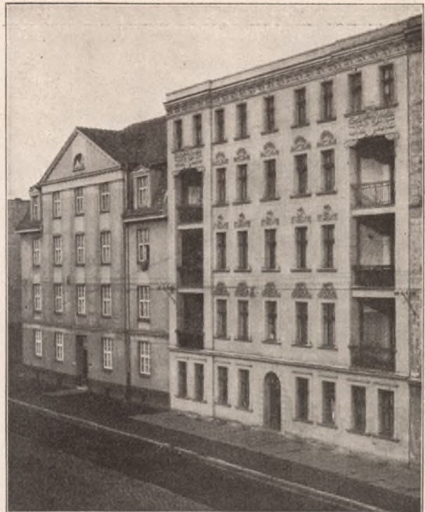
Abb. 4. Wohnhäuser in der Friedrichstraße
