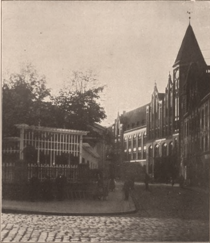
Niederwallstraße mit Hauptpostamt
