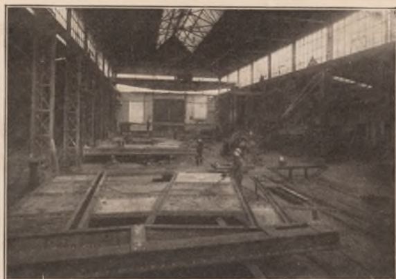
Teilansicht: Abt. Eisenkonstruktion
