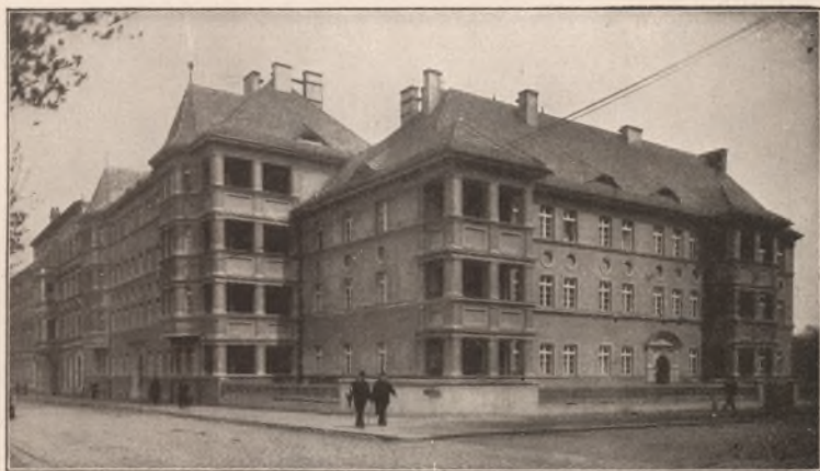
Abb. 12. Wohnhäuser der Gräfl. Vassestremischen Verwaltung an der Ecke Molke- und Bitterstraße
