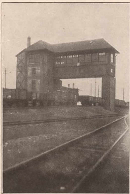
Abb. 2. Das über dem Scheitelpunkt des Ablaufberges stehende Stellwerk 3 losgefuppelte Wagen rollen eben vom Berge ab
