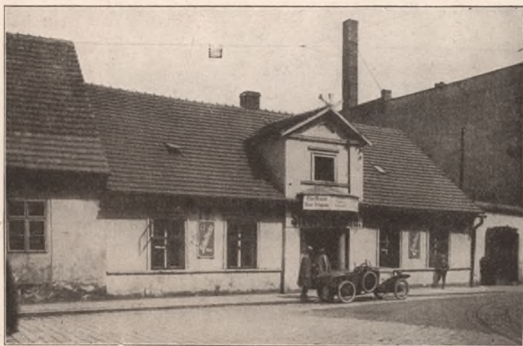
Abb. 2. Gasthaus „Stadt Troppau“ (alter Zustand)
