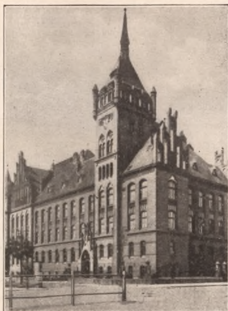
Maschinenbau- und Hüttenerschule
