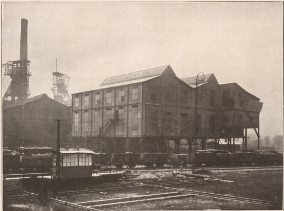
Bild 1 Separation und Schiebebühne Ludwigsglückgrube b. Vorfiswerk
