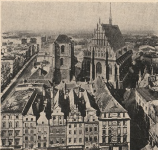
3. Blick auf die Jakobipfarrkirche in Neisse
