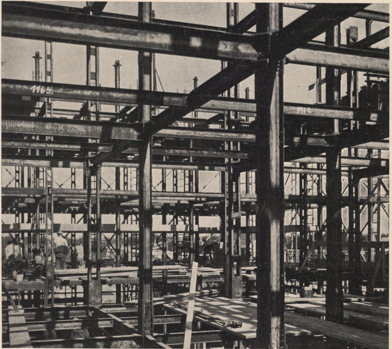
Der Spielzeugkasten unserer Jungen ins Große übertragen: Aus fertig verpaßten Stücken wird in wenigen Wochen das Gerippe eines fünfstöckigen Hauses zusammengebaut. Man sieht deutlich die Schrauben an den Verbindungsstellen zwischen Trägern u. Stücken.
