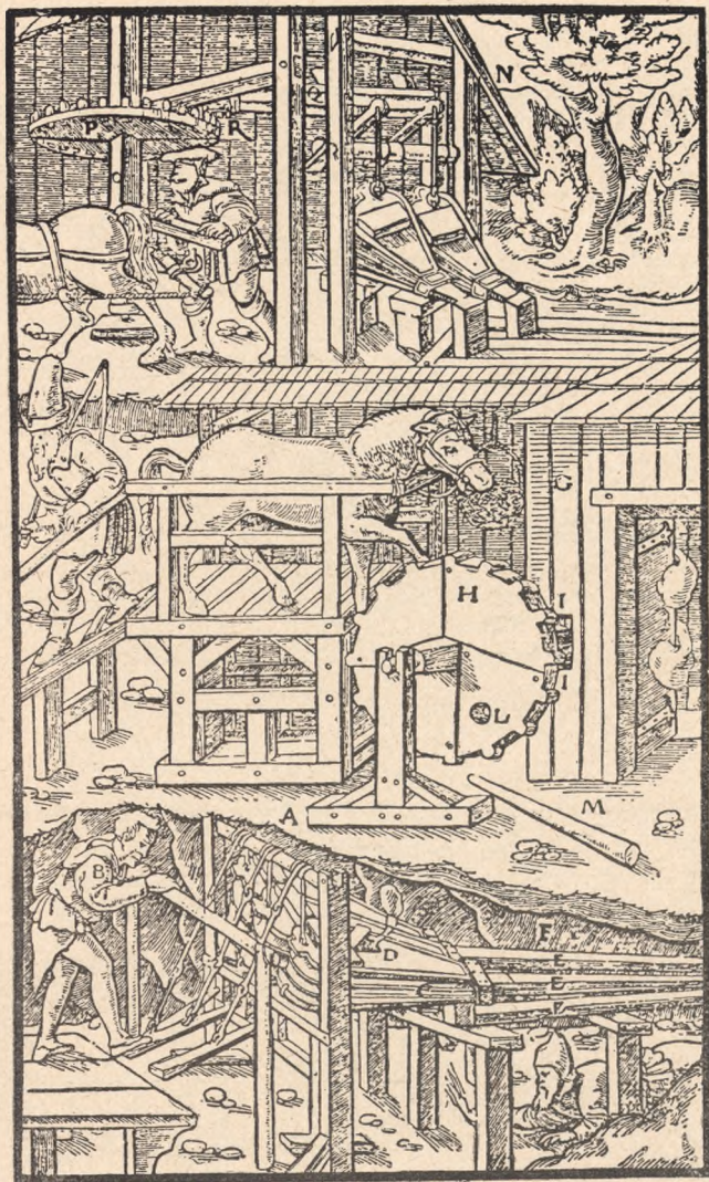
Różne sposoby doprowadzania powietrza do kopalni (Agricola).
