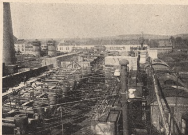
Urządzenia rafineryjne w Drohobyczu („Dros“)
