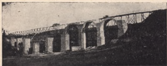
Wiadukt w budowie na linii kol. Sambor-Uzsok
