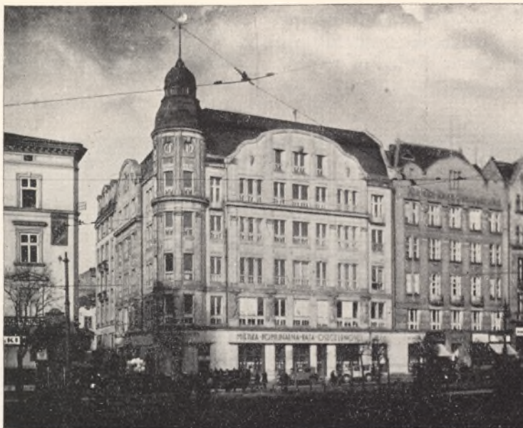
Gmach Miejskiej Komunalnej Kasy Oszczędności we Lwowie. Centrala przy ul. Wałowej 7 i 9.
