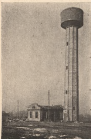
Wieża wodna dla Zjednoczon. Fabryk Związków Azotowych w Mościcach.
