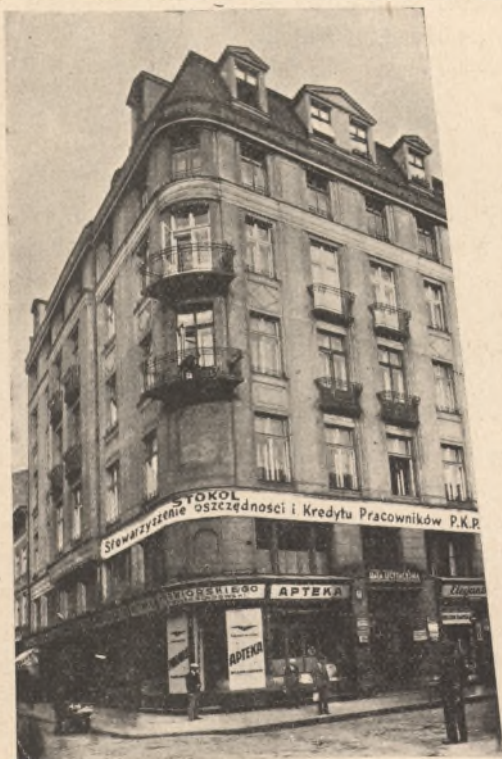
Siedziba Stow. Oszczędności i Kredytu Pracowników P.K.P. we Lwowie. Dom własny przy ul. Halickiej 19
