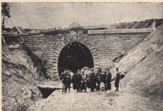
Tunel Łuszczany na linii kol. Sambor-Uzsok
