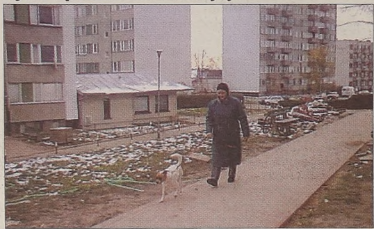
Zniszczone płyty chodnikowe zastąpiono kostką.
