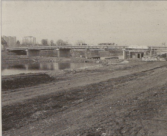
Konstrukcja mostu spięła już oba brzegi kanału.
