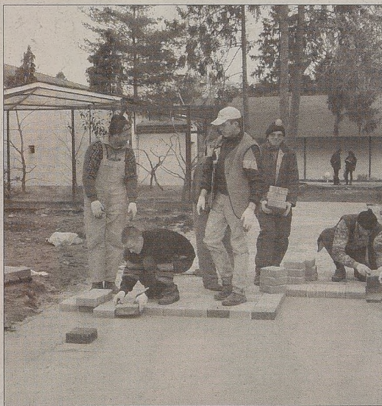
Robotnicy układają alejki spacerowe w starej części zoo kostką brukową. W przyszłości wszystkie alejki zostaną odremontowane w ten sposób.
