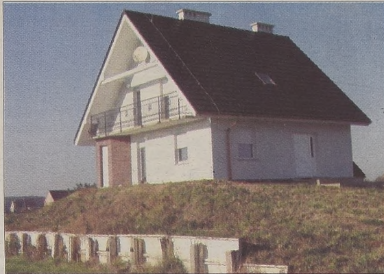
Dom został posadowiony na 2,5-metrowej górze. Na podsypkę poszło sześćset kubików ziemi.
