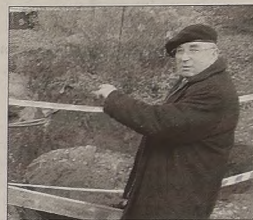
Radny Ryszard Czerniński pokazuje: - Przez te stare fundamenty trzeba było wstrzymać prace.
