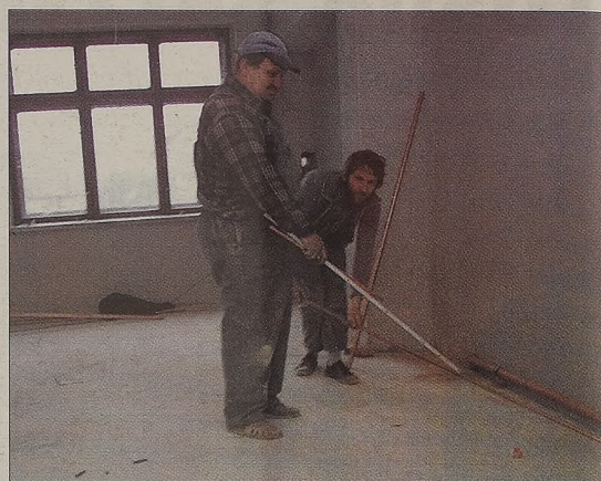
Piotr Rozik i Jarosław Jung instalują w ścianach remizy rury, którymi niebawem popłynie woda.
