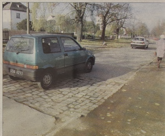
Polwod nie ma pieniędzy na położenie na ulicy Wiejskiej zerwanego przez siebie asfaltu.
