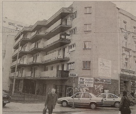
Konstrukcja budynku sprawia, że straty ciepła są tu duże.
