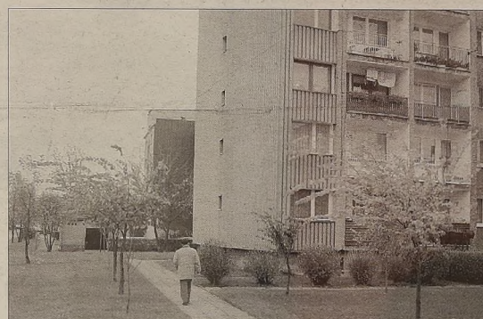
Jedna ze ścian bloku przy ul. Morcinka jest już ocieplona.
