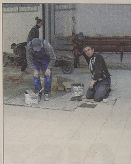
Na początku grudnia Savia otworzy drugi ze swych supermarketów w Opolu, na osiedlu ZWM. Trwa tam układanie płytek.
