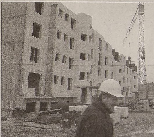
Powstaje kolejny dom. Na pierwszym planie mistrz budowy Ryszard Krawiec.
