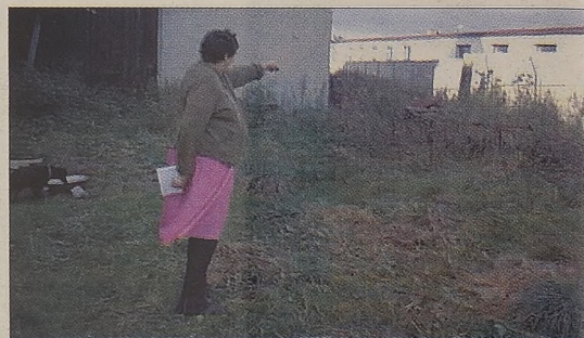
- W tym miejscu mam przerwane drenaże w ziemi, więc do wody w piwnicy dostają się nieczystości - pokazuje Stefania Mudra.
