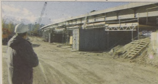
Konstrukcja nośna jest już gotowa.
