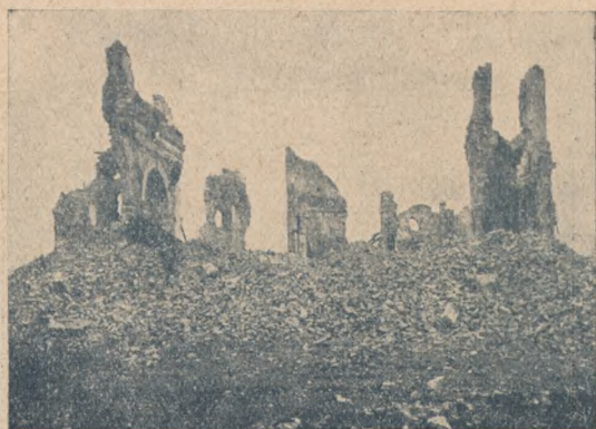
Kościół rozbity granatami na odcinku naszego pałacu przed Piawą.
