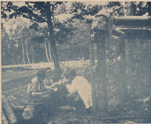
Budowa „chaty” tuż za linją. Od lewej: Piórzak, Nowak, Orlicki i Heizler. Do bariaczka z kawą wlewam mleko kondensowane. Lipiec 1916 r.
