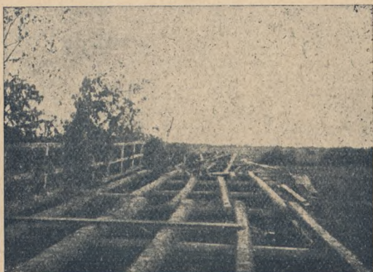
Torfiasty i błotnisty teren na Wołyniu nie zawsze zezwalał na budowę rowów strzeleckich w ziemi. Oto na odcinku naszego pułku budujemy umocnienia nad ziemią.
