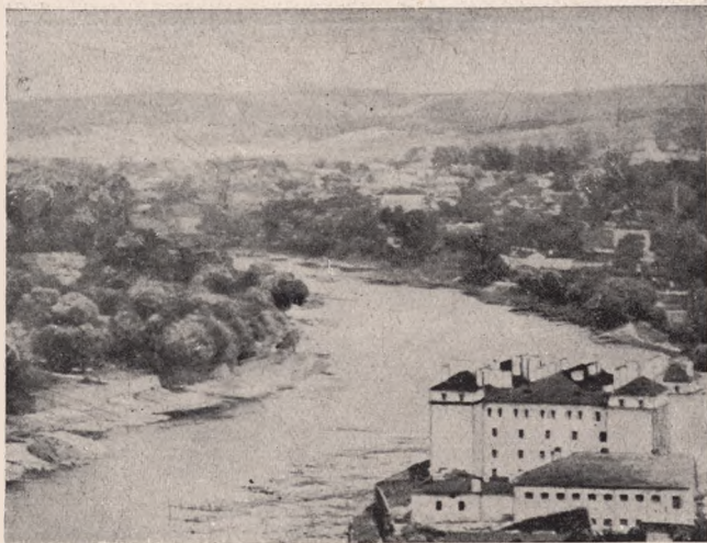
Wilno. Widok na Wilgę i Antakol.
