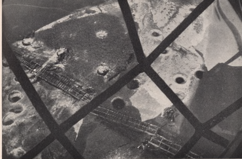
Luftbild einer Holzbrücke, die im Feuer der Kampfflieger in Flammen aufgegangen ist. Auf der Insel sind zahlreiche Bombeneinschläge zu sehen
