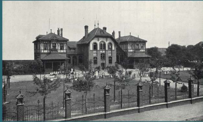
Szkoła dla najmłodszych dzieci na osiedlu patronackim w Mysłowicach, ok. 1913. Z: Das Arbeiterwohnungswesen in der Oberschlesien .
