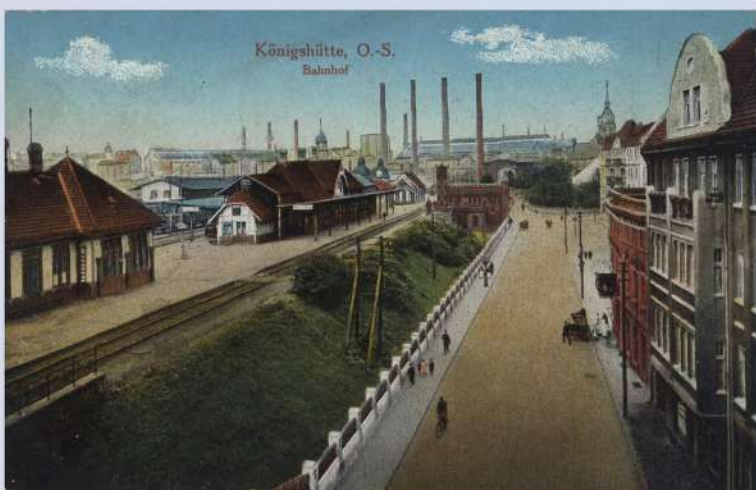
Dworzec kolejowy w Chorzowie (dziś stacja Miasto Chorzów), ok. 1915 (ŚBC).
