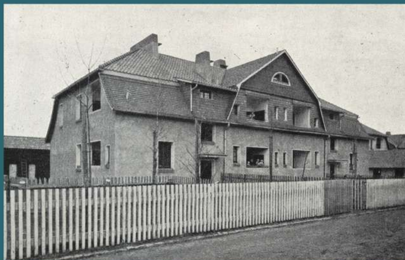
Dom dla dziesięciu rodzin na osiedlu patronackim w Knurowie, ok. 1913. Z: Das Arbeiterwohnungswesen in der Oberschlesien .
