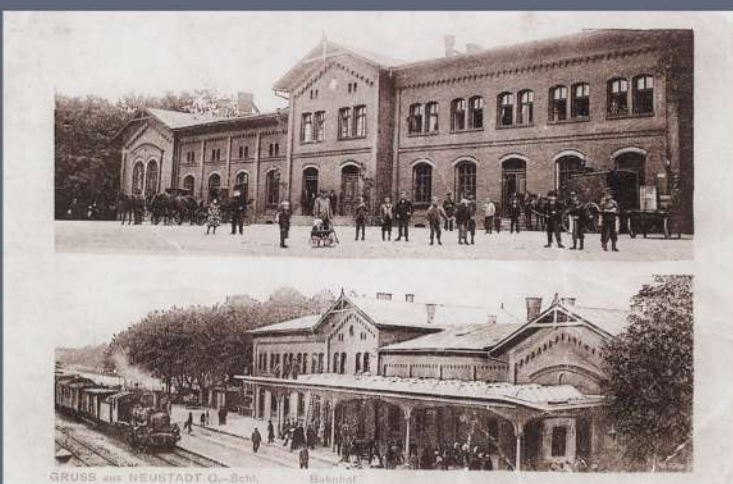
Dworzec w Prudniku, ok. 1905. Z : Prudnik na dawnej pocztówce.
