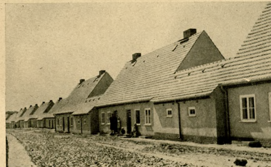
Die große Arbeitersiedlung bei Odertal im Entstehen
