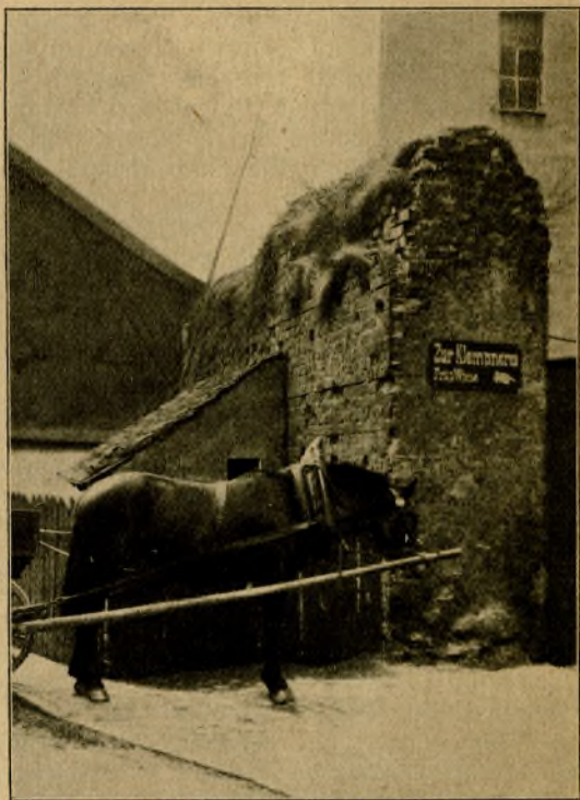
Alte Stadtmauer in Kreuzburg.
