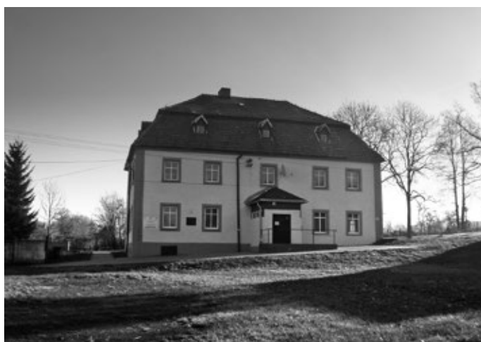
Fot. 4. Budynek dawnej plebanii, widok od zachodu, fot. autorki
