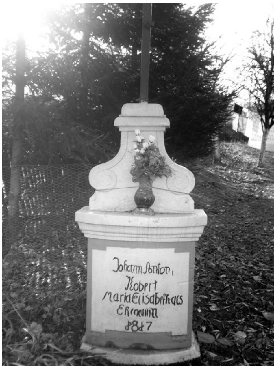
Fot. 8. Kapliczka z 1817 r., przykład niewłaściwej renowacji, fot. autorki
