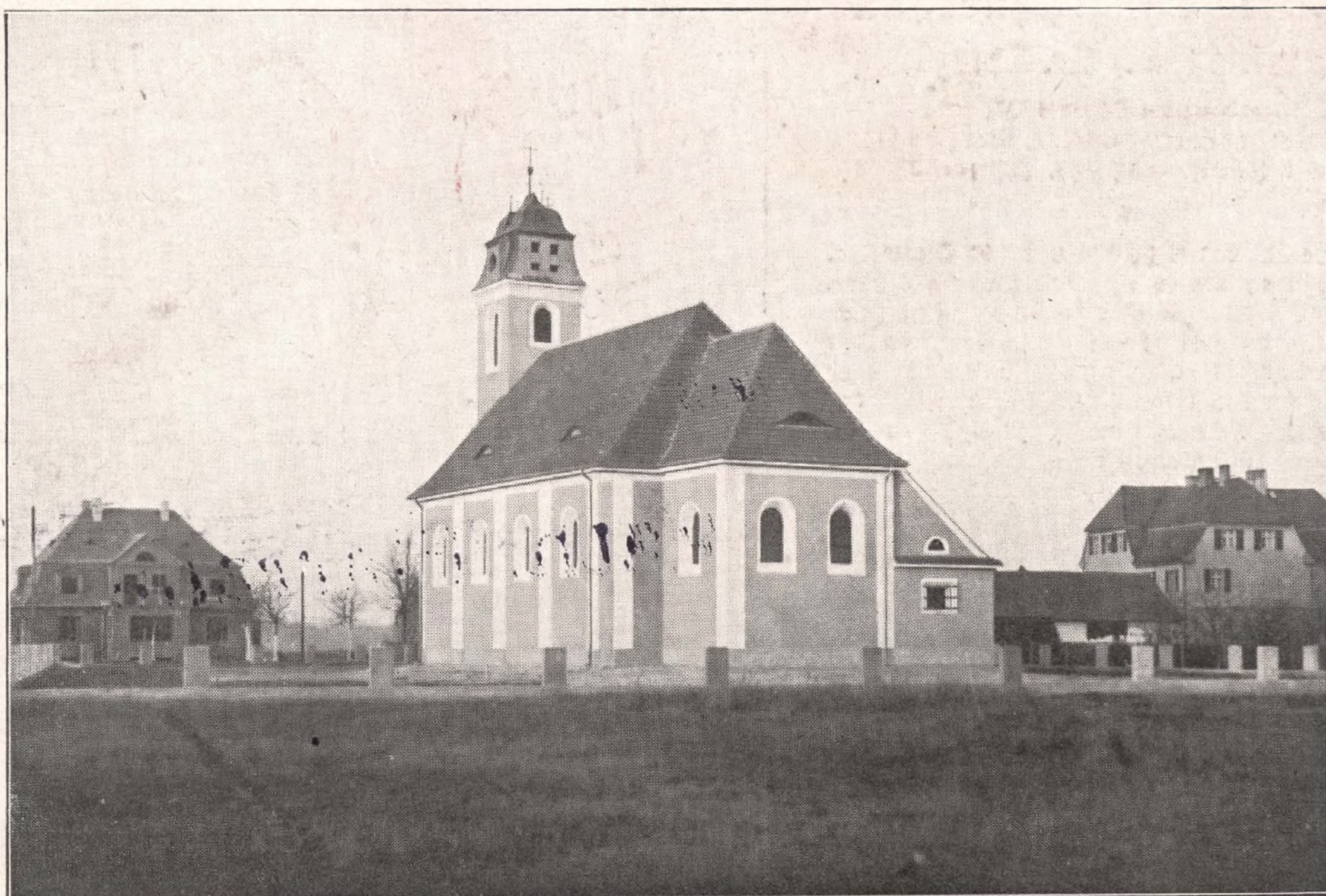
Kath. Kirche nebst Pfarrhaus in Zawisz O.S., Kr. Kreuzburg erbaut im Jahre 1928 von Architekt Hanns Schlicht, Breslau 13, Opitzstraße 3 (am Höfchenplatz). Fernsprecher 35933
